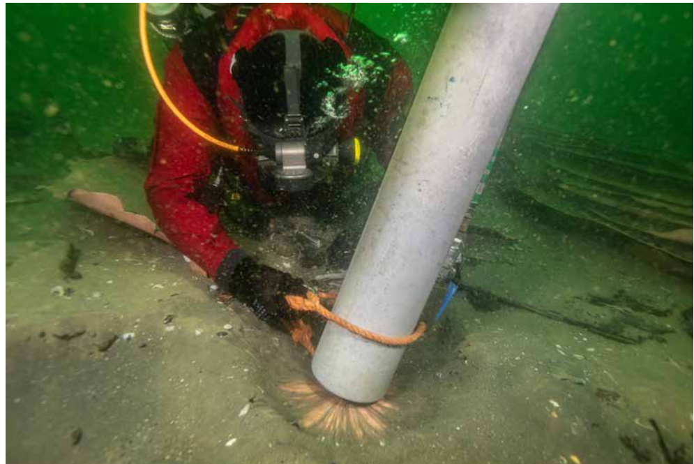
Afb. 15 Duiker met airlift om de mobiele zandlaag te verwijderen.
