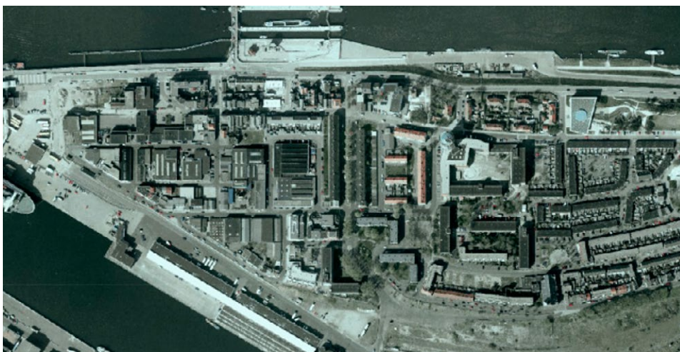
De wand in de Oranjestraat werd afgebroken om het kleinschalige grid weer terug te brengen.
